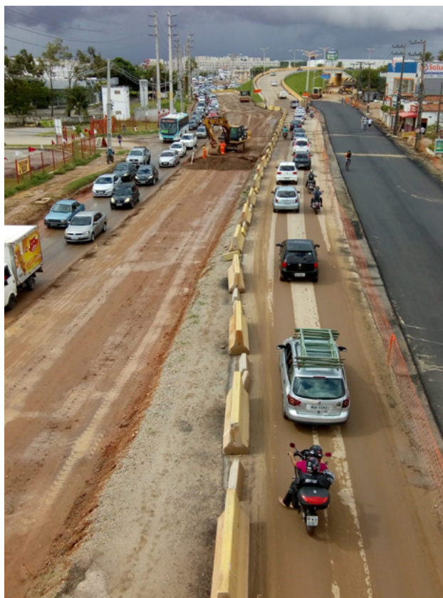
Figura 3 — Tráfego de veículos durante a obra
