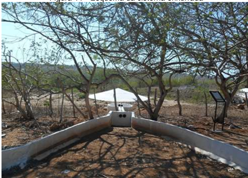
Figura 11 - Esquema da cisterna enxurrada
