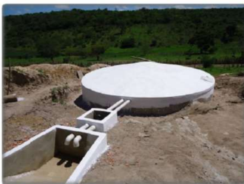
Figura 3 - Ilustração da cisterna do tipo enxurrada
