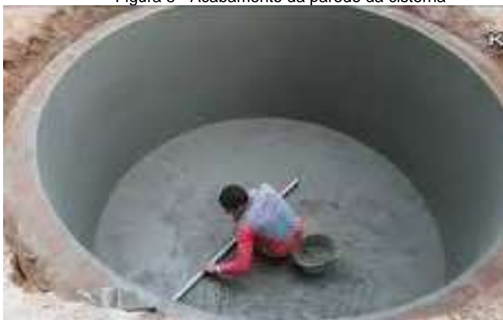
Figura 8 - Acabamento da parede da cisterna
