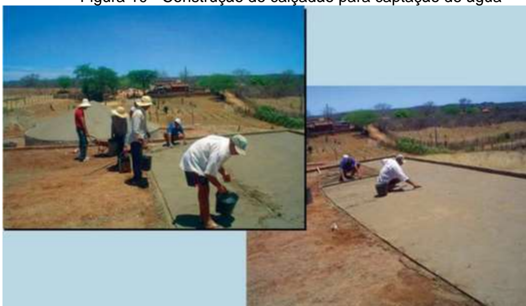
Figura 10 - Construção do calçadão para captação de água
