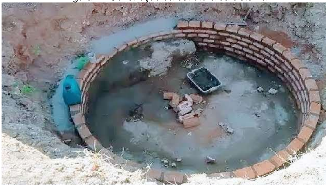
Figura 7 - Construção da estrutura da cisterna
