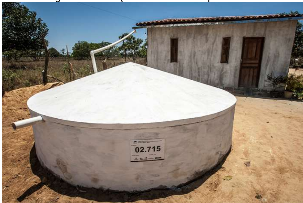
Figura 1 - Ilustração da cisterna do tipo alvenaria
