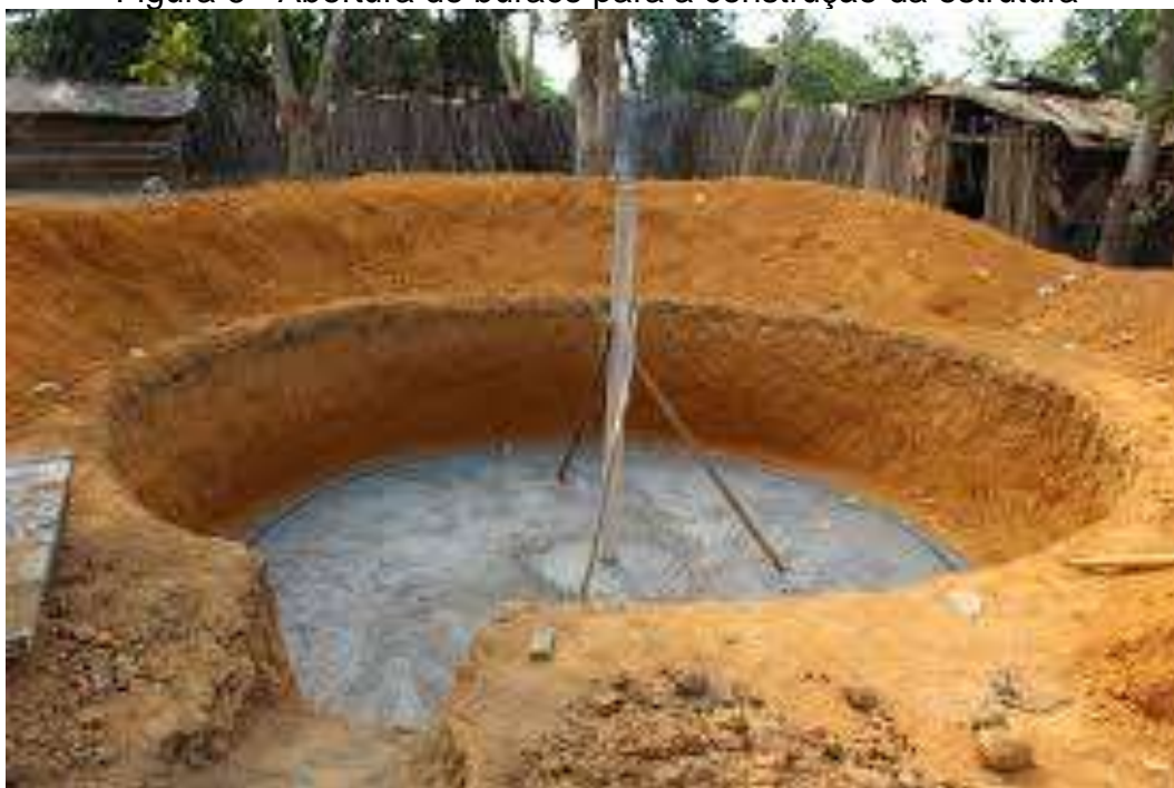
Figura 6 - Abertura de buraco para a construção da estrutura
