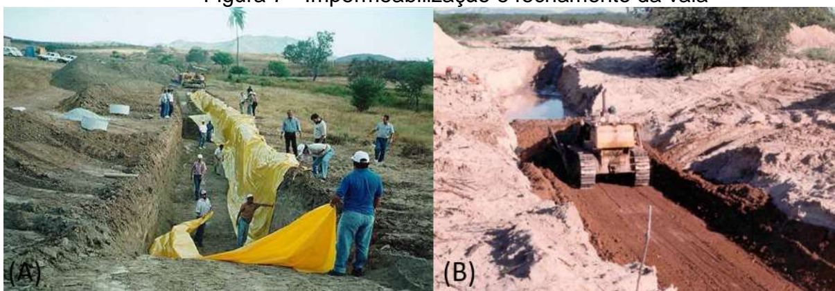
Figura 7 - Impermeabilização e fechamento da vala
