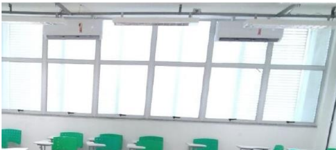
Imagem 4: Instalação de aparelhos de ar condicionado nas salas de aula
