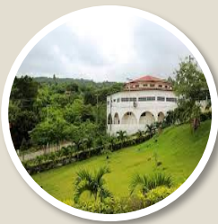
CRATO RODOVIA CE - 292, GISELIA PINHEIRO. 63115-500 CRATO - CE
