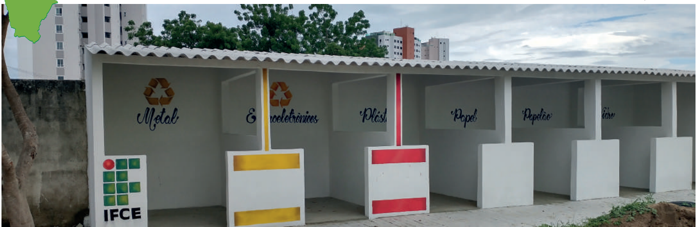
Foi construído um local exclusivo para o armazenamento dos resíduos coletados no IFCE
